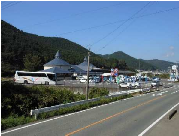
道の駅 どんぶり館
